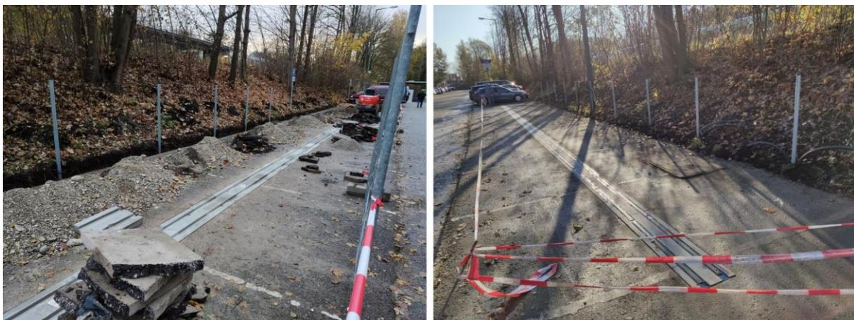
**Abb. 4: Installation der Sensoren auf der Park-and-Ride-Anlage Lochhausen Nord in München**
